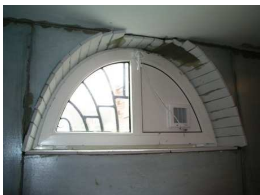
klejenie nietypowego ościeża
