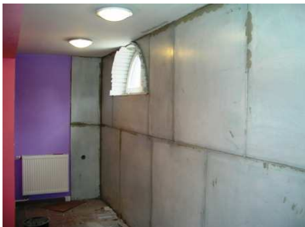
zakładki na ścianie działowej - podczas montażu
