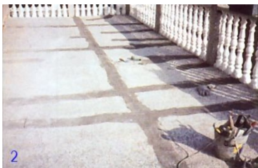
Spękania tarasu pokrytego lastrico naprawiane sposobem gospodarczym przez właściciela przez kilka kolejnych lat.
