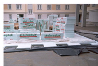
izolacja drogi pożarowej
