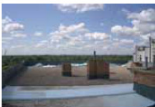
izolacja dachu płaskiego
