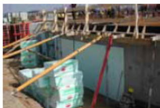
izolacja ściany fundamentowej
