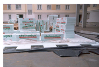
izolacja drogi pożarowej
