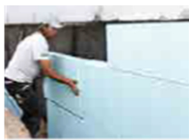
izolacja fundamentów, ścian piwnic, cokołów
